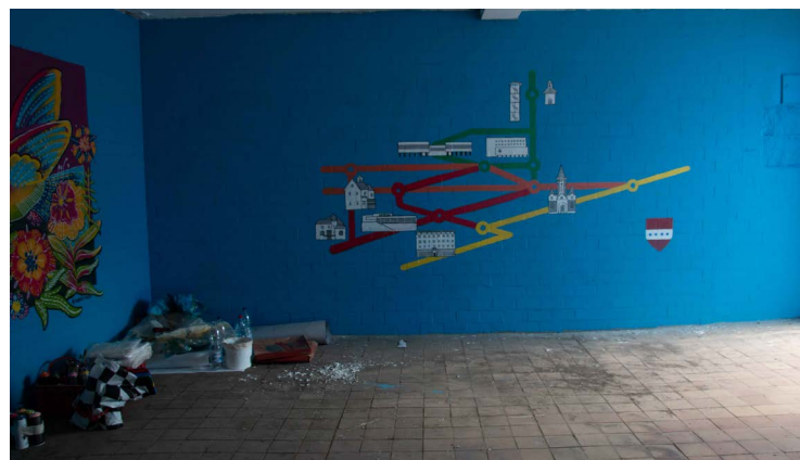
Opravený podchod Bieblova
