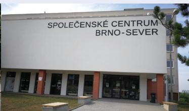
Opravené Spol. centrum s Family/Senior pointem
