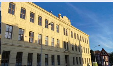
Opravená škola nám. Republiky
