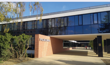
Opravená Poliklinika Lesná
