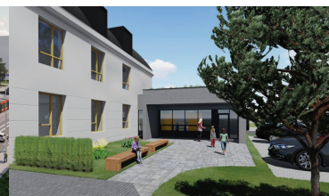
Nové šatny v základní škole v Soběšicích
