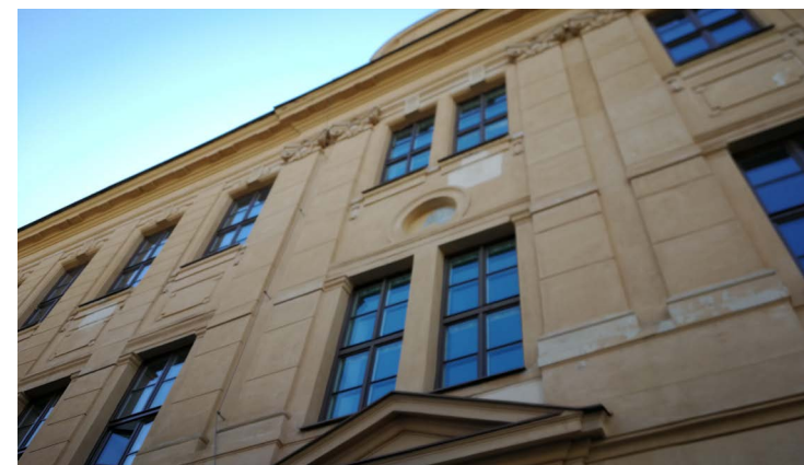
ZŠ náměstí Republiky – opravíme fasádu a provedeme vnitřní rekonstrukci
