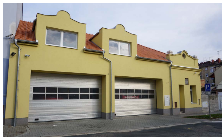
Opravená hasičská stanice
